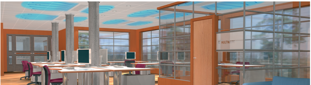
Billede 6. Et separat kontor skal passes ind i rummet. Hvis klimaet skal være optimalt, skal luftmængden og luftfordelingen justeres på Premax bafflen, der bygges ind i det nye rum.
